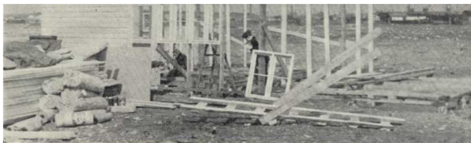
Sådan så der ud på byggepladsen i påsken 1953
